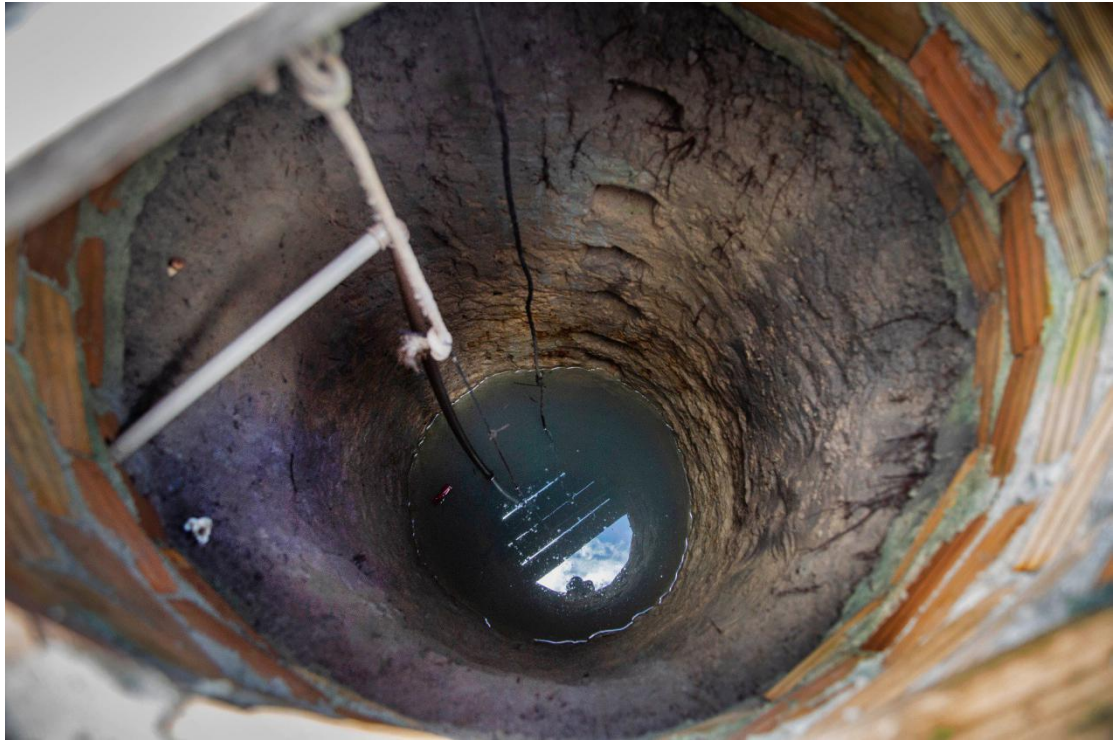
A construção de um poço clandestino pode acarretar na secagem de nascentes e aquíferos. Fonte: Outra Saúde
