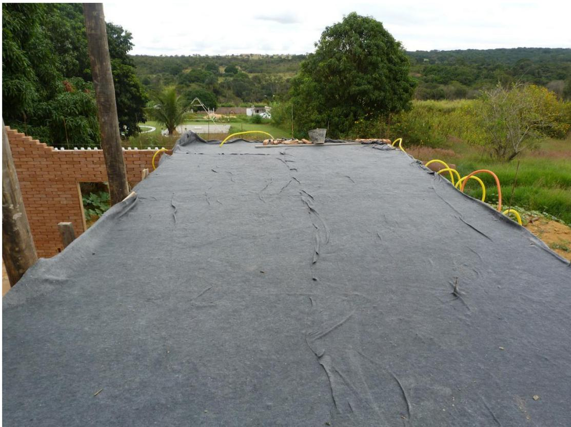
Manta geotêxtil cobrindo a laje
