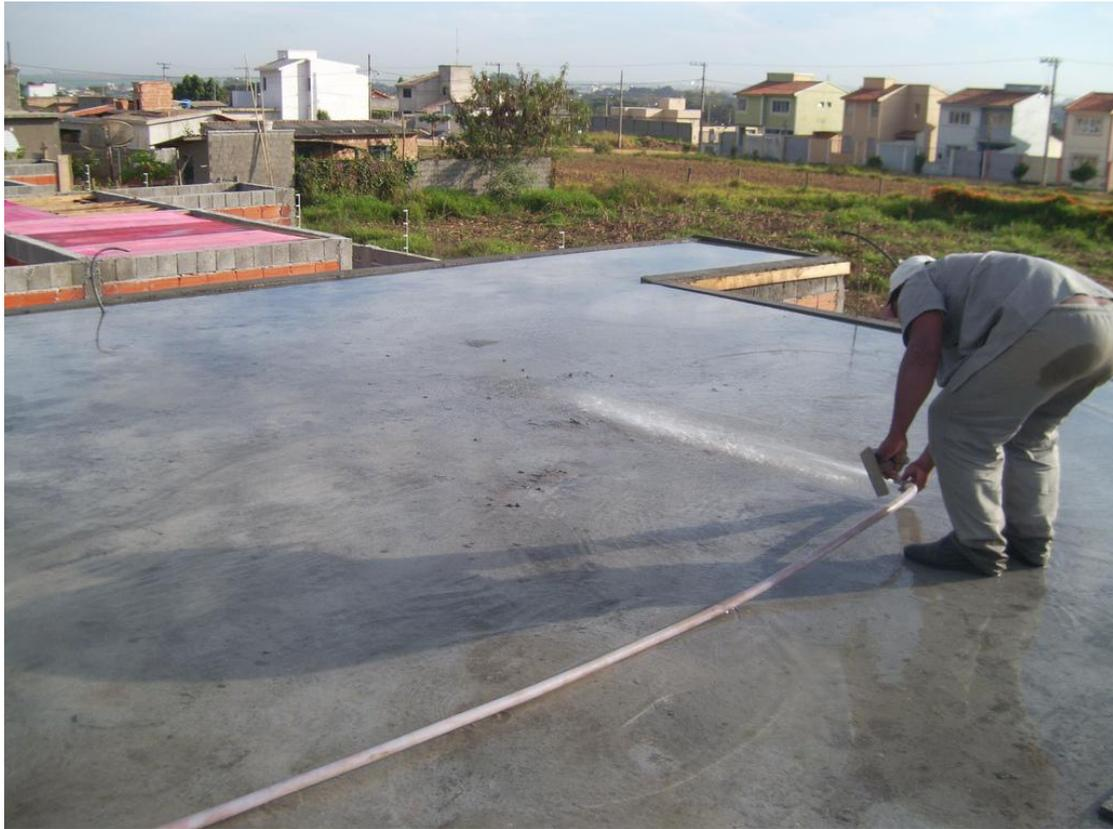
Processo de molhagem em uma laje que visa a boa cura do concreto
