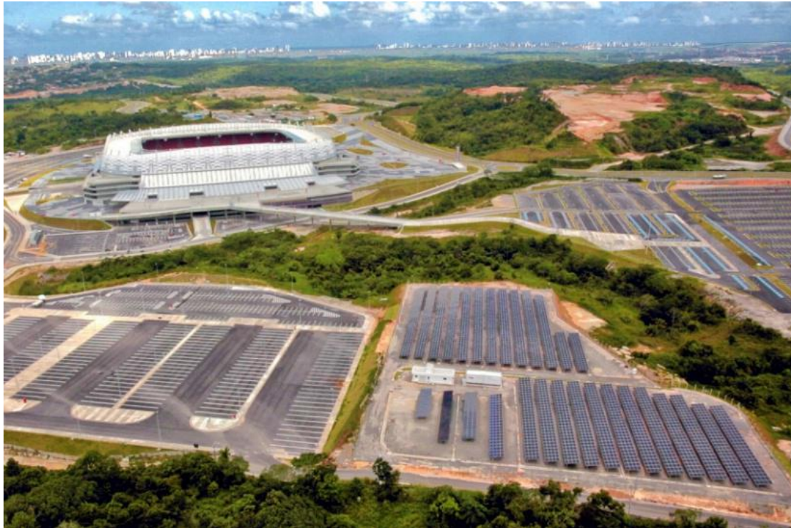
A Arena Pernambuco possui uma usina solar anexa ao estádio. Fonte: Portal da Copa
