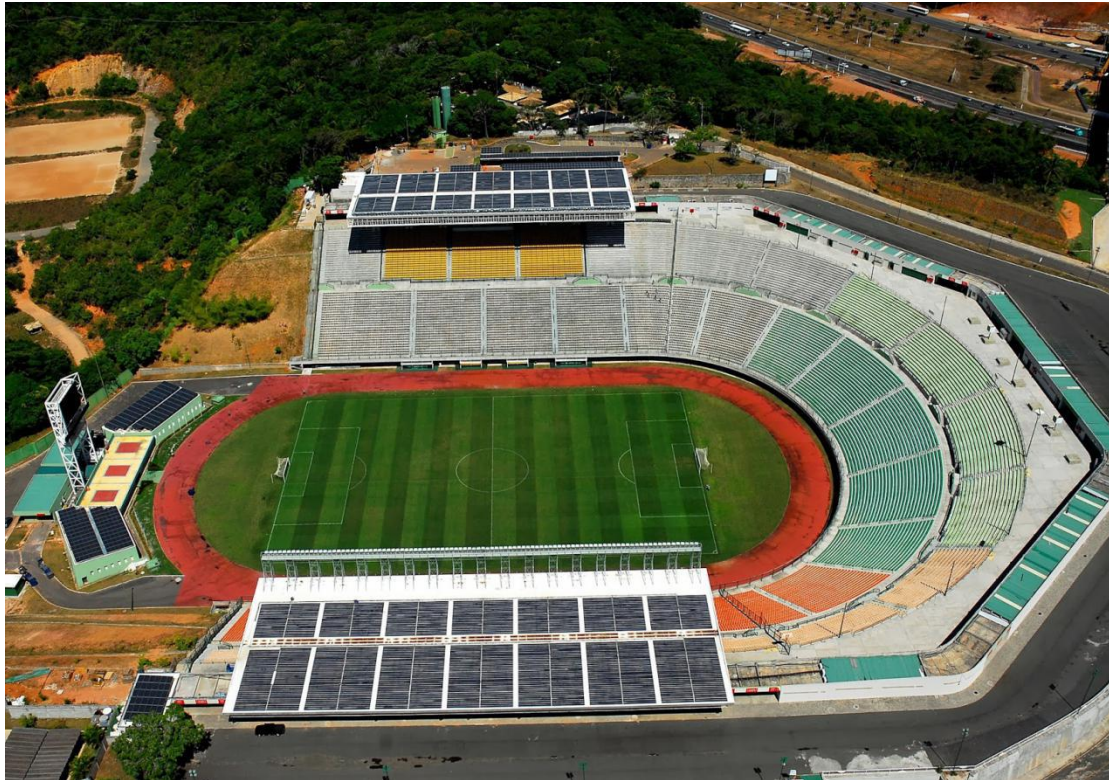
Os painéis solares do Pituuaçu estão nas coberturas da arquibancada e estacionamento. Fonte: Salvador Notícias
