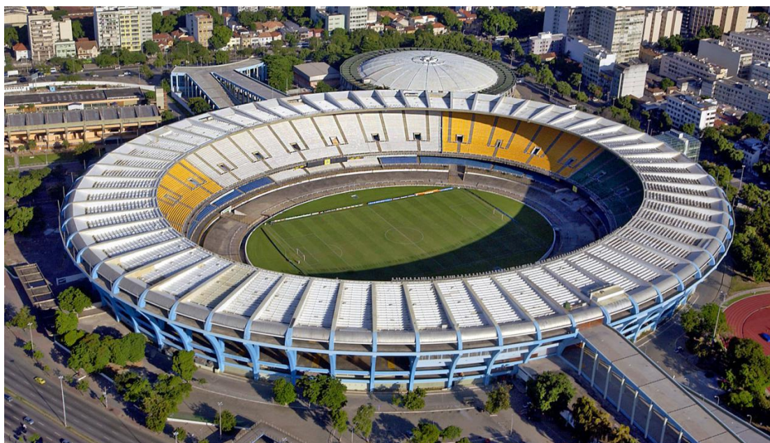
A cobertura do Maracanã abriga 1.552 painéis fotovoltaicos. Fonte: S&P Clever Reinforcement
