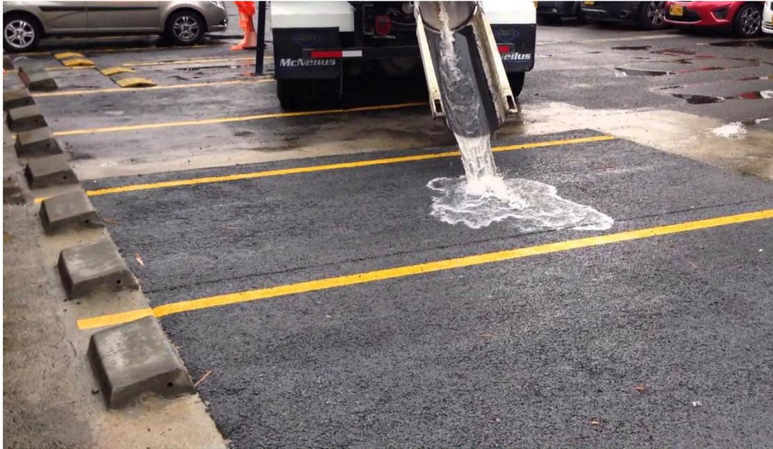
O concreto permeável aumenta a permeabilidade de pavimentos submetidos a cargas reduzidas
