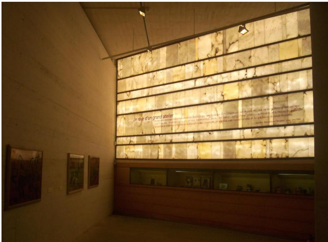
Iluminação natural interna de um ambiente com o uso de uma parede com o concreto translúcido
