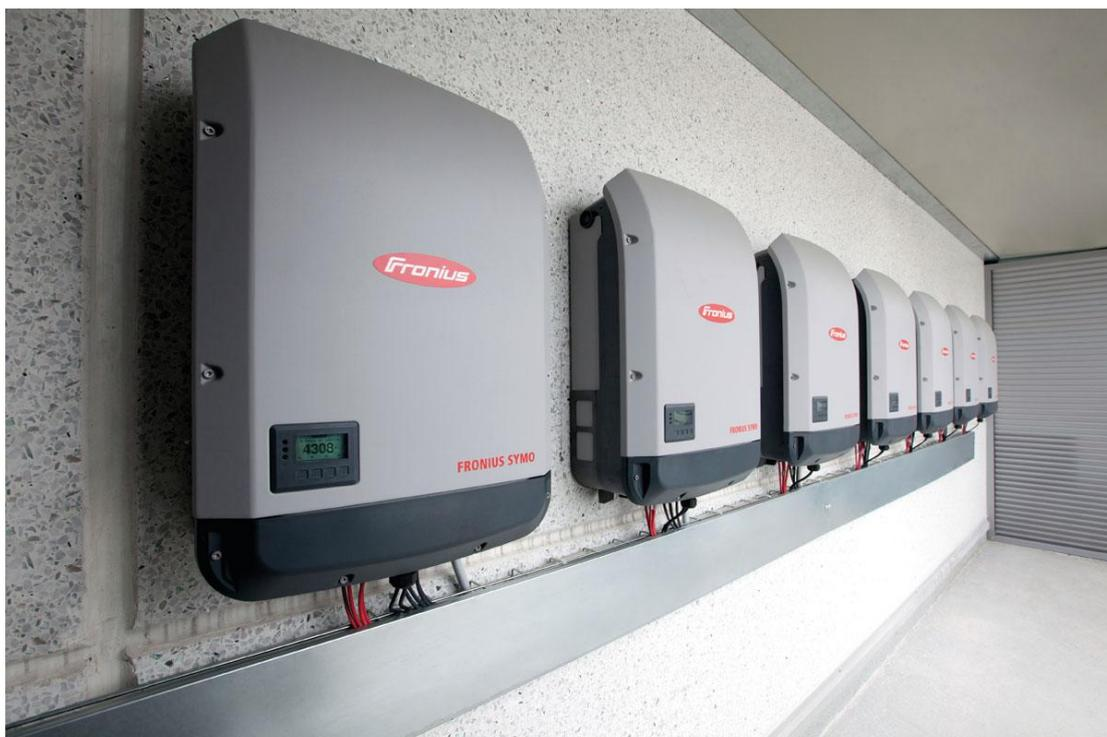
Inversores solares utilizados para conversão da corrente contínua em corrente alternada. Fonte: Dusol
