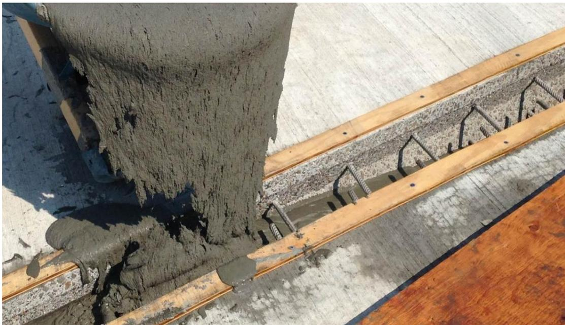
O concreto UHPC conta com resistência à compressão maior que 20.000 psi, o que significa 138,0MPa. Foto: Pixabay
