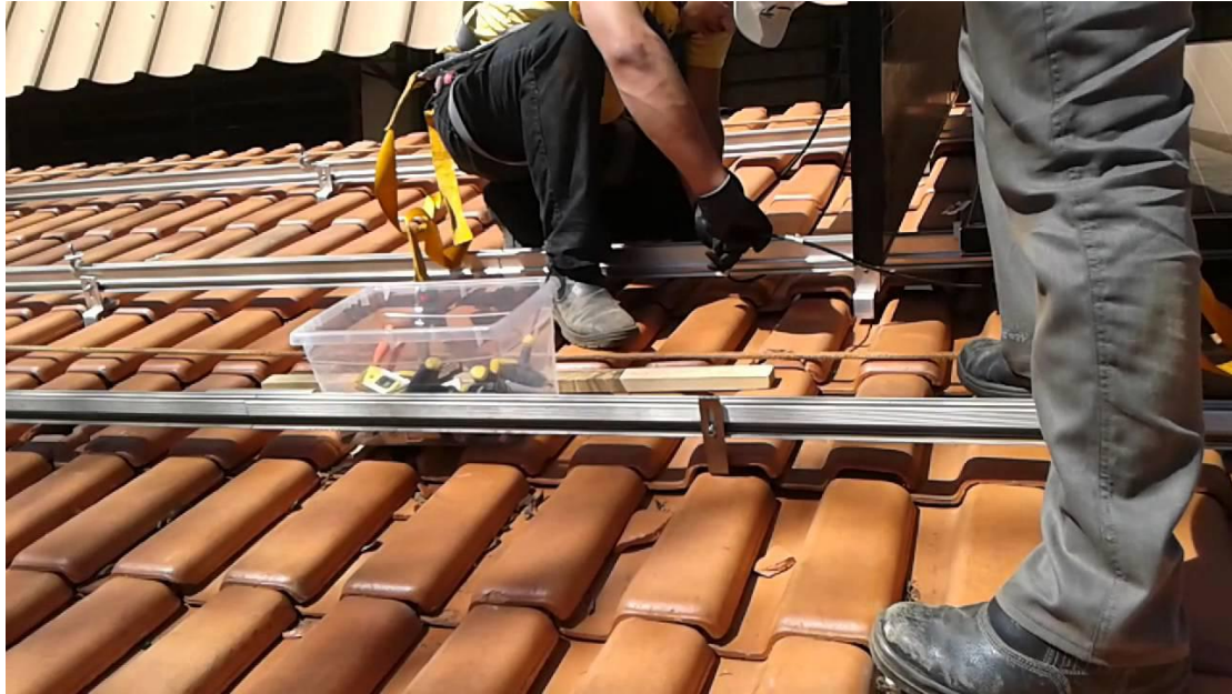
Trilhos preparados para receberem as placas fotovoltaicas. Fonte: YouTube
