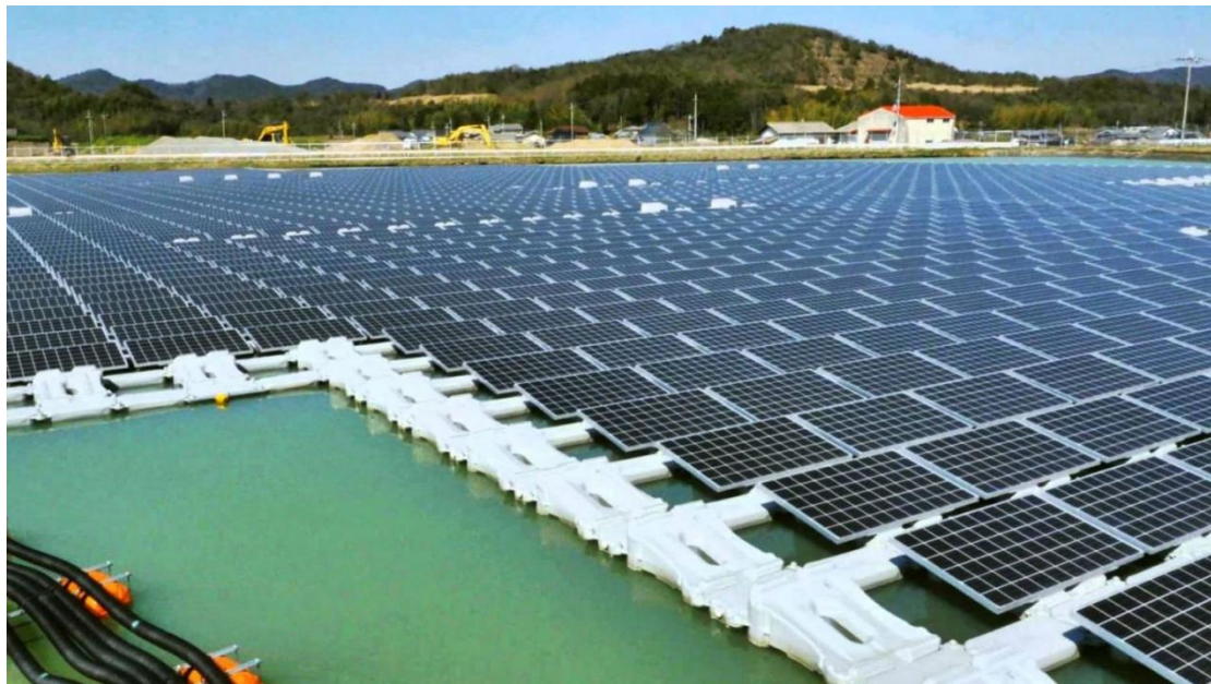
Usinas construídas na água geram mais energia comparada àquelas construídas no solo. Fonte: Eleksolar
