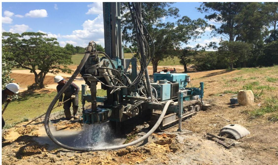
O terreno deve medir no mínimo 8 metros de comprimento por 3 metros de largura. Fonte: Portal dos Poços
