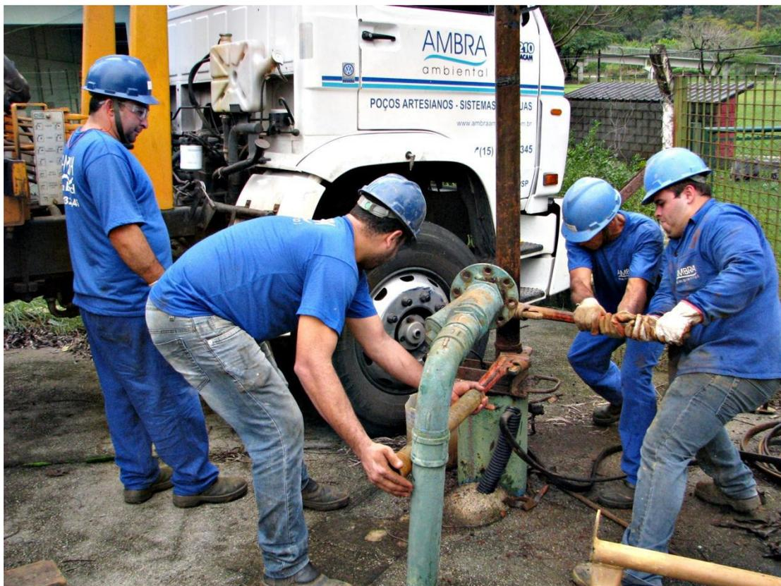
O teste de vazão visa determinar a real capacidade de captação de água. Fonte: Agência Sorocaba de Notícias
