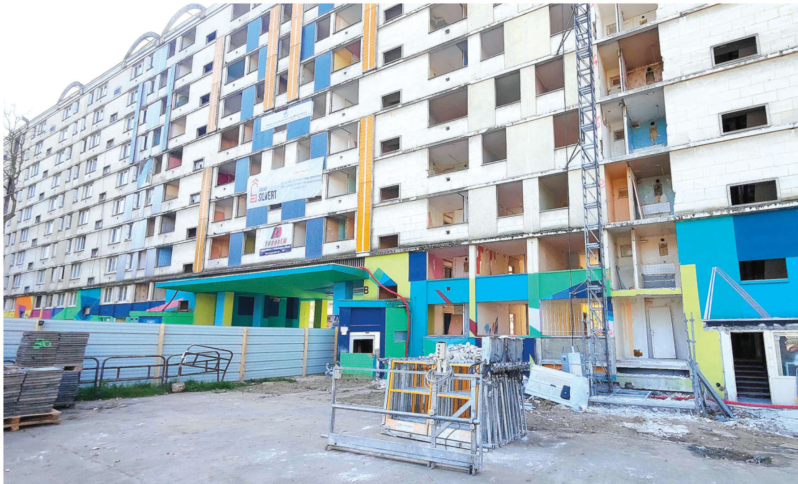
À la fin de l'été, cette barre d'immeuble, la plus grande de Picardie, sera démolie à Beauvais.
