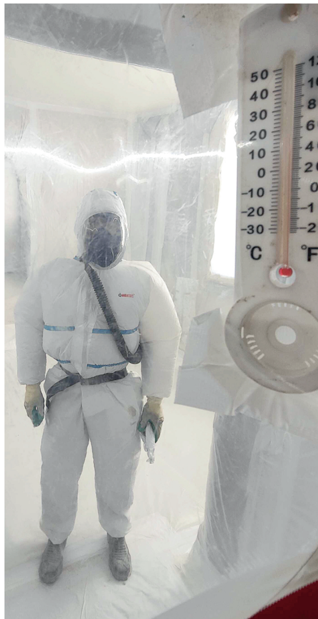
À l'intérieur de la bulle c'est dans cette tenue que les ouvriers s'attèlent à enlever l'amiante.
