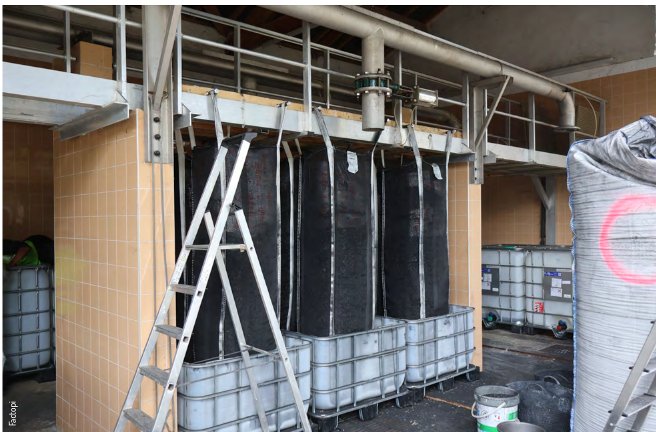
Factopi possède un laboratoire pour traiter les urines. Ici, des filtres à charbon.
