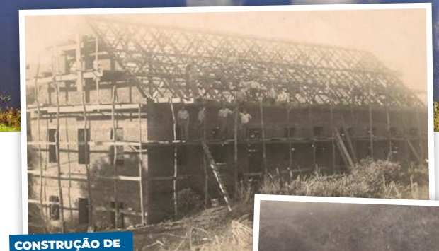
CONSTRUÇÃO DE CASA COMERCIAL NO CENTRO DA CIDADE
