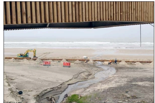
1,5 kilomètre de canalisations d'acier a été installé sur la plage sud de Soulac-sur-mer. ARCHIVES JDM
