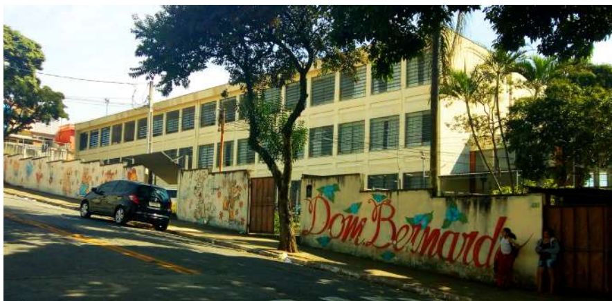
Fachada da escola Dom Bernardo, que sofreu com os problemas de carpinagem
