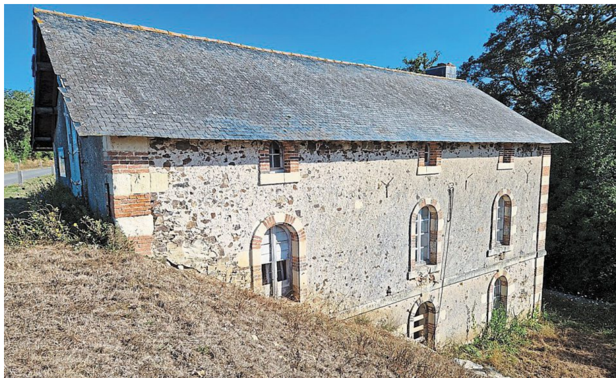
Derrière la digue de l'étang de Beaurepaire, l'ancien moulin prend place. Détruit lors des guerres de Vendée, il a été reconstruit et consolidé.
