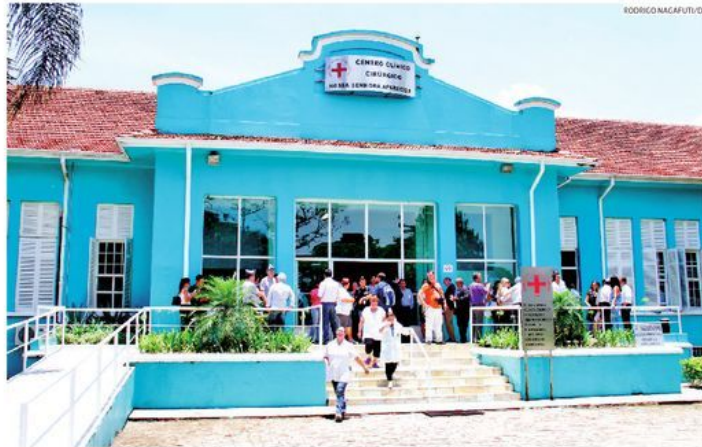
CLÍNICA DE DEPENDENTES Será instalada no hospital Arnaldo Pezzuti, em Mogi
