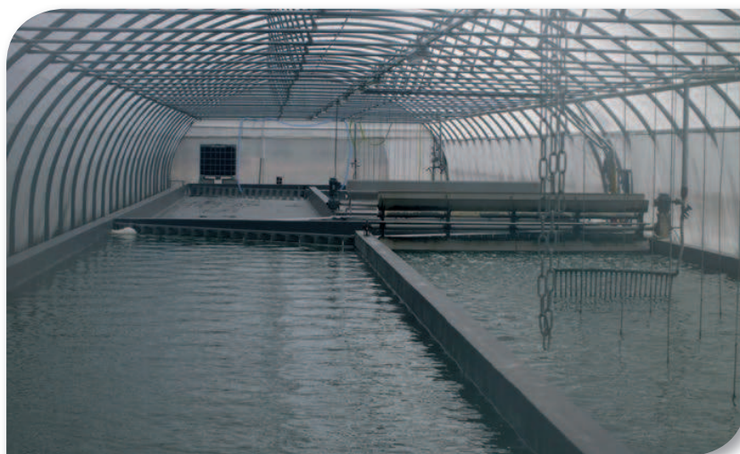
L'entreprise a construit sur le terrain de M. Onno une serre de 650 m 2 , contenant 2 bassins de 250 m 2 chacun.
