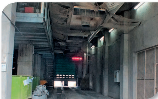
Trois tunnels de chargements accueillent les camions de livraison.
