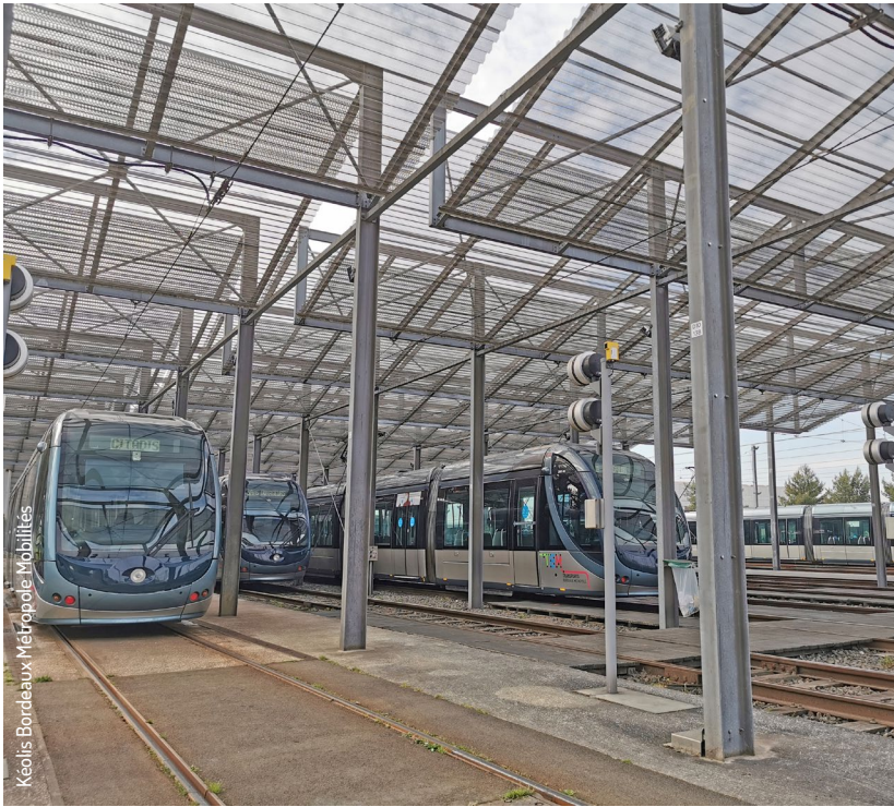
À Bordeaux, le stationnement des trams sous des ombrières permet d'éviter une surchauffe dans les rames.
