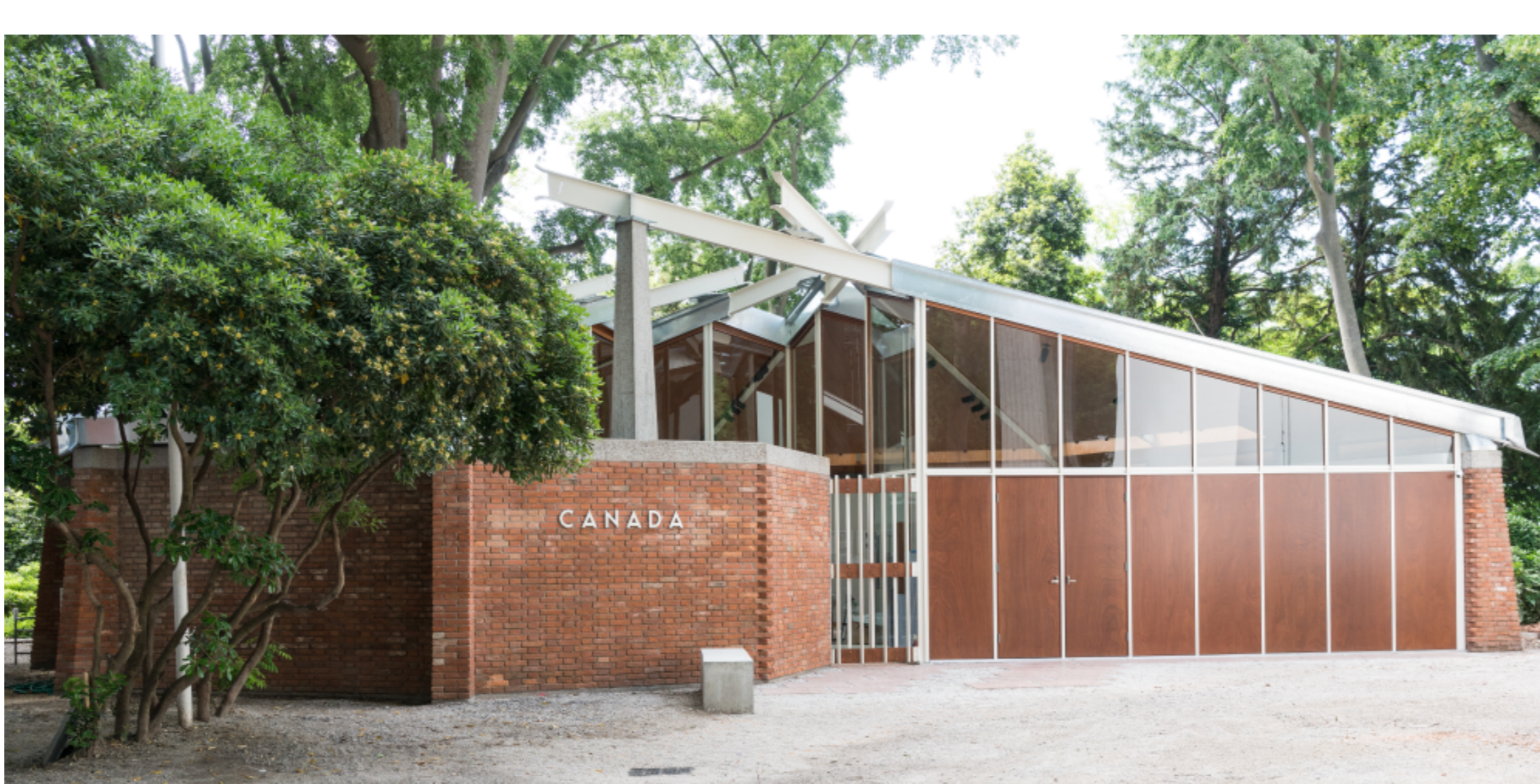
Canada Pavilion, view of newly restored pavilion, 2018, Giardini di Castello, La Biennale di Venezia, Venice. Photo: Andrea Pertoldo.
