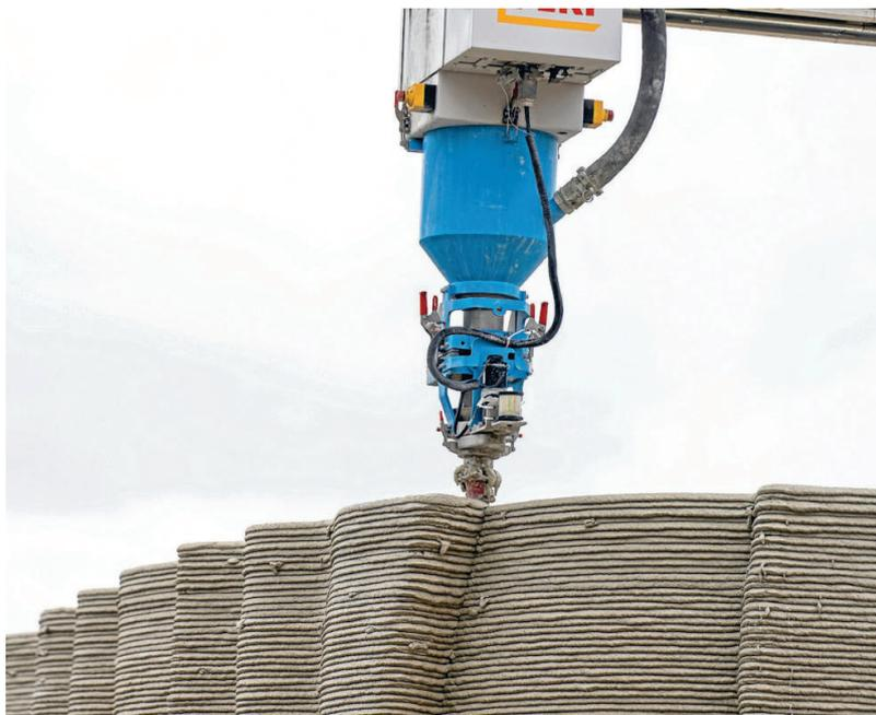
Schicht auf Schicht statt Stein auf Stein: In Heidelberg entsteht derzeit das größte 3D-Druck-Gebäude Europas. Heidelberg Materials liefert dafür rund 450 Tonnen eines Hightech-Spezialmörtels, der laut Konzern ein CO<sub>2</sub>-optimiertes Bindemittel enthält. Fotos: Heidelberg Materials
