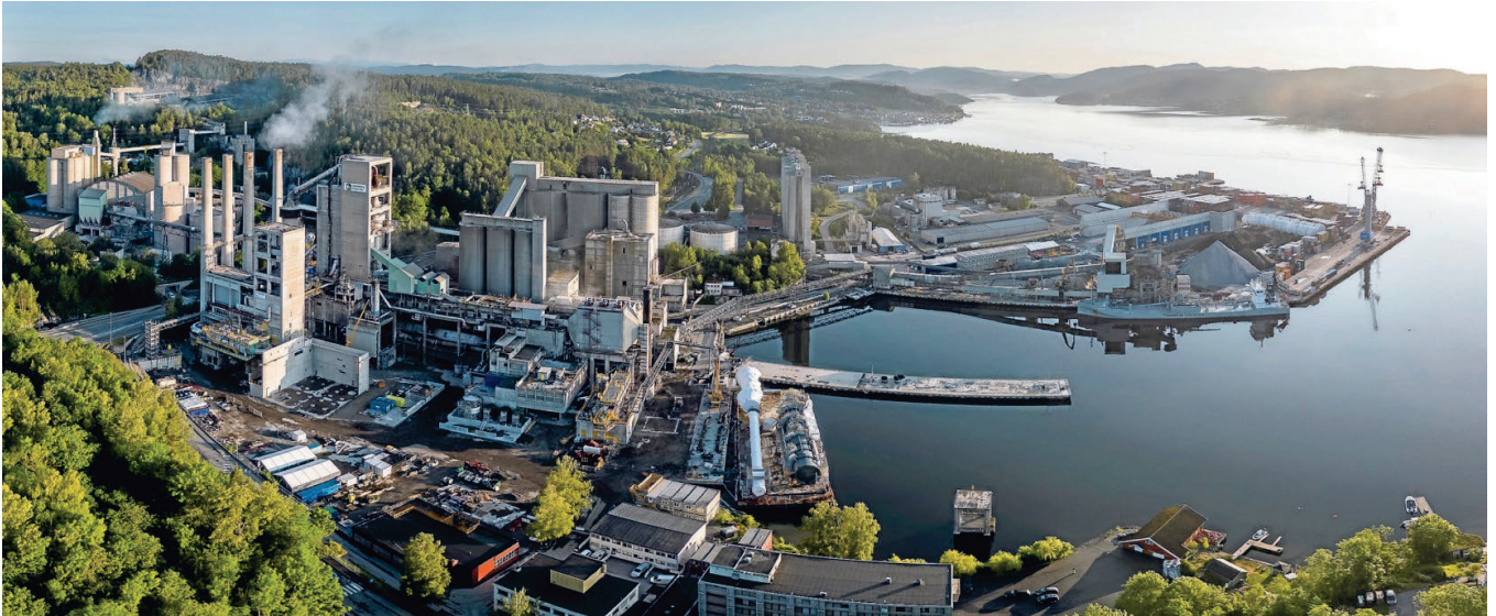
Zementwerk von Heidelberg Materials im norwegischen Brevik. Hier entsteht die weltweit erste großindustrielle Anlage zur Kohlenstoffabscheidung und -speicherung in der Zementindustrie. Fotos: Heidelberg Materials
