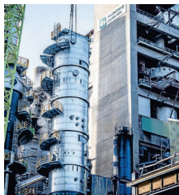
Installation des Desobers als Teil der CCS-Anlage in Brevik im Frühjahr 2024.
