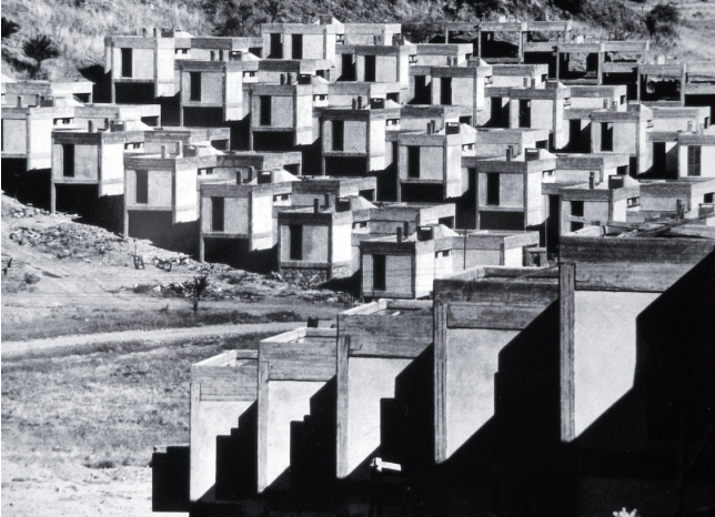
Artur Arkent under construction, Balıkesir (early 1970s) from SALT Research, Altuğ and Behruz Çinici Archive / Artur Arkent yapım aşamasında, Balıkesir (1970'lerin başları). SALT Araştırma, Altuğ ve Behruz Çinici Arşivi
