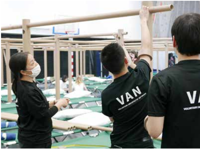
Shigeru Bans papprör monteras av Voluntary Architects Network i ett boende för ukrainska flyktingar. Paris 2022.
